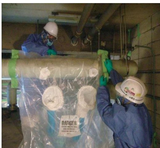
図30 グローブバッグによる局所的な隔離 28)
