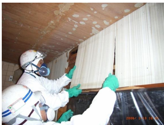
図39 手ばらしによる成形板の除去
