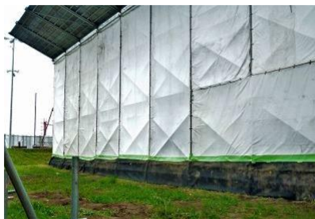
周囲への飛沫飛散防止養生例（外部）
