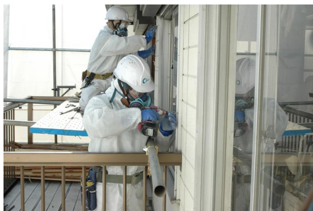
図40 ネジの取り外し及び手ばらしによる除去の共同作業
