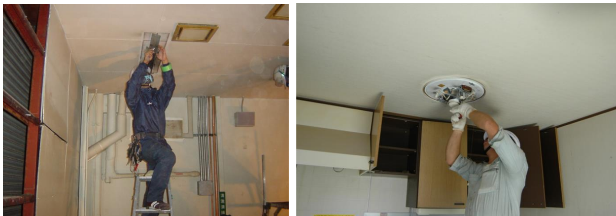
図38 照明器具の撤去状況
