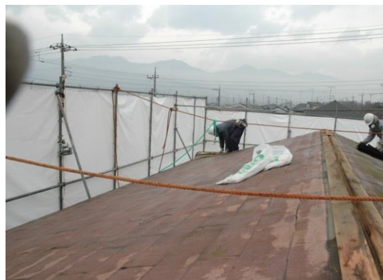
図44 命綱を付けた除去作業
