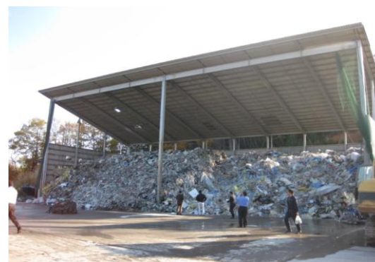
積替保管施設
