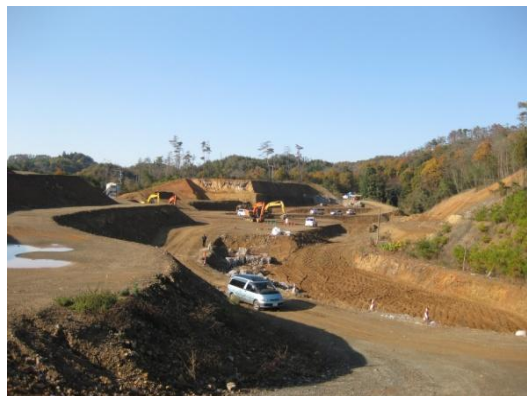
処分場全景(奥から入口に向かって)
