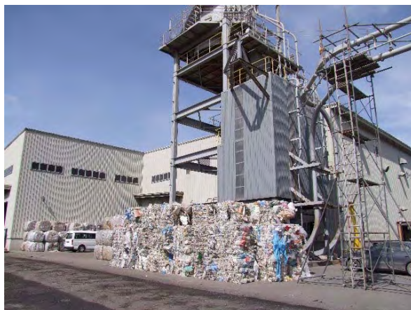
廃プラ破碎プラント
