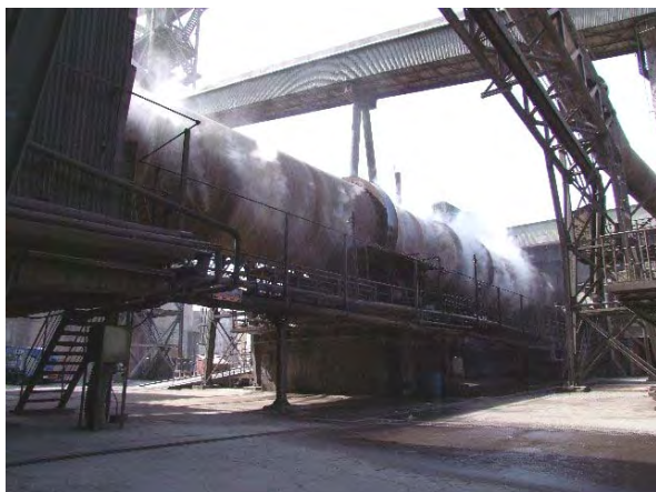
稼働中のキルン
