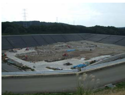
(株)東環 管理型最終処分場
