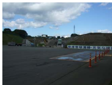
仙台環境開発(株)管理型最終処分場
